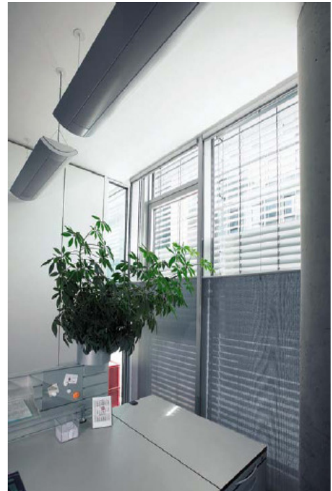
Afbeelding 30: tweedelig lamel systeem, waarbij het bovenste deel het diffuse licht in de diepte van de ruimte reflecteert.
